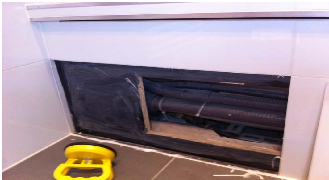
Un MAUVAIS exemple d'une trappe d'accès
